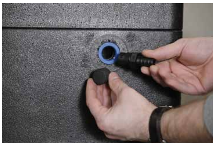
Tilslutning af kondensafløb
